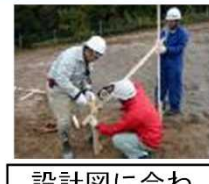
設計図に合わせて丁張り設置
