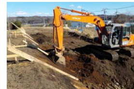
丁張りに合わせて施工
