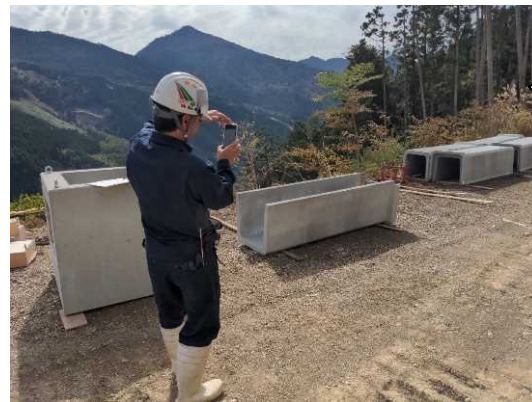
【立会状況（現場）】
