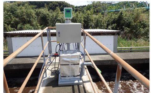
図11 浄化槽BOD監視システム
