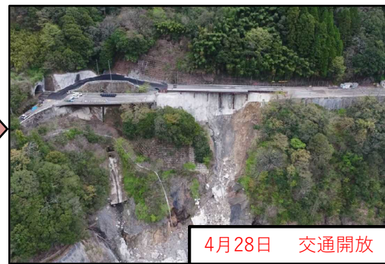
応急復旧状況
