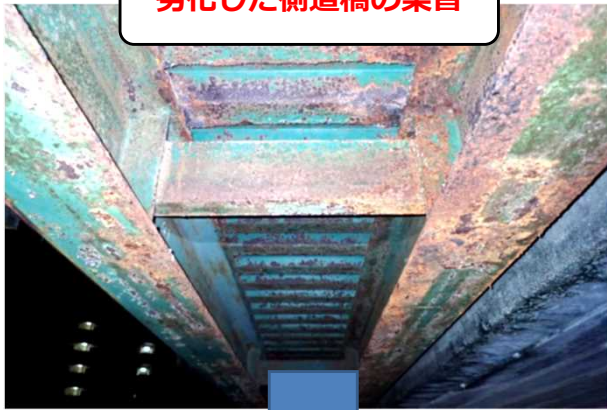
劣化した側道橋の架替
