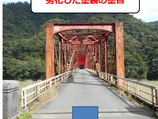
劣化した塗装の塗替
