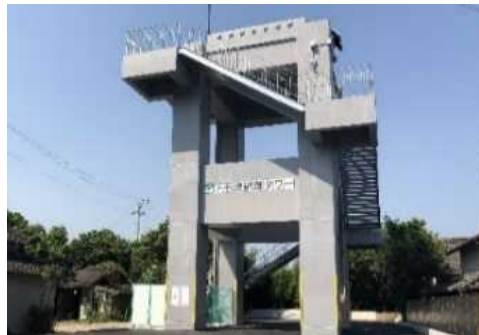
下石波地区避難タワー (串間市)
