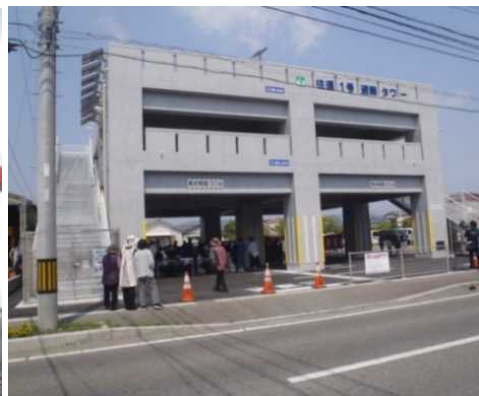
往還①地区避難タワー (日向市)
