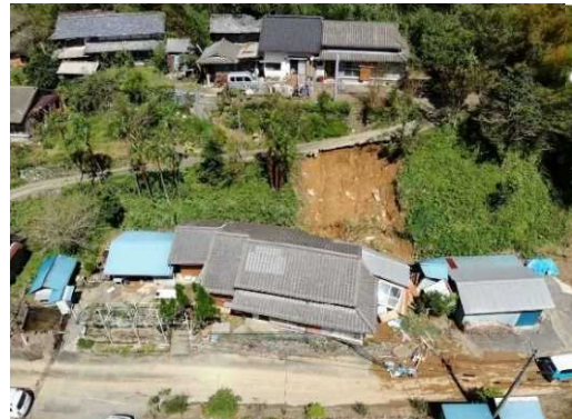
下渡川地区がけ崩れ状況 (日向市)
