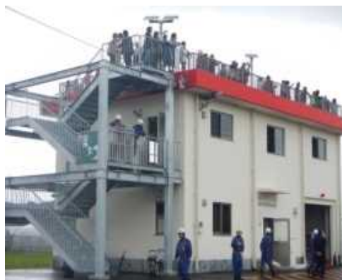
横江地区複合型津波避難施設 (新富町)
