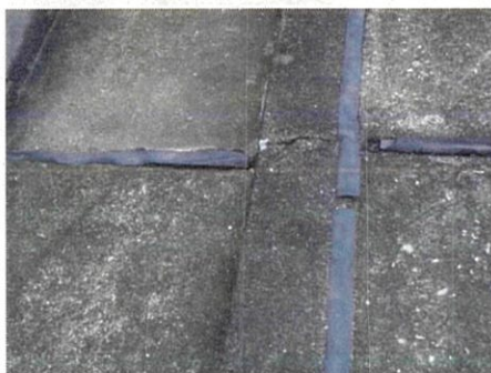
屋上防水現況
