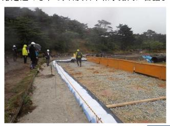
○5/14(通水開始直後) 水が石灰石内に浸透し、接触時間が確保 される事により、中和効果を発揮
