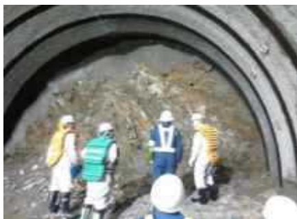
学識者による工法検討状況
