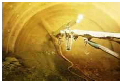
吹付コンクリートの実施状況
