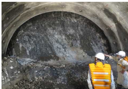
学識者・受注者・発注者による工法検討状況
