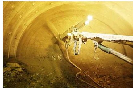
吹付コンクリートの実施状況
