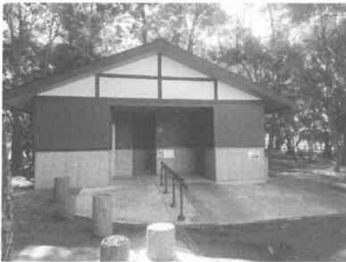
県有施設（トイレ）の改修
