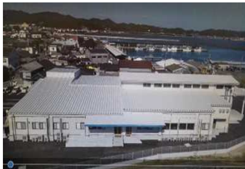
HACCP対応の施設整備
