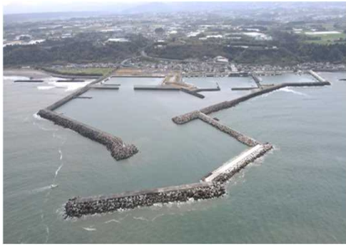
川南漁港 防波堤の新設
