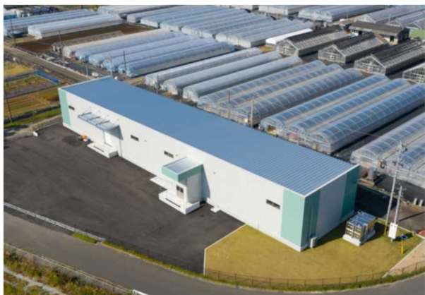
人の感染症との共用資材を一元管理する備蓄倉庫
