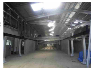
ロータリー攪拌機付き 堆肥化施設
