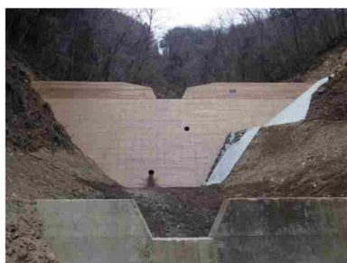
(1)③ 自然との調和に配慮したダム工事 (木製残存型枠の採用)
