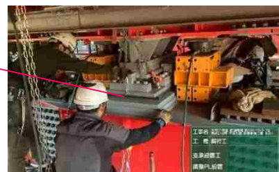
調整プレート設置状況
