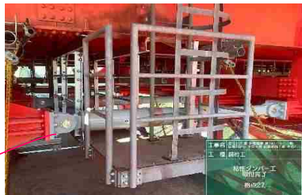
新設部材と検査路配置
