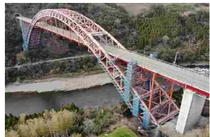
足場設置状況
