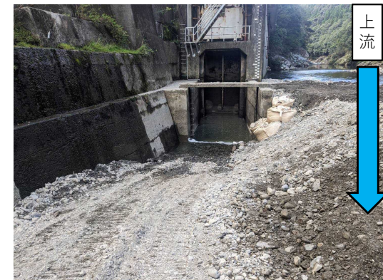
祝子発電所放水口 復旧後
