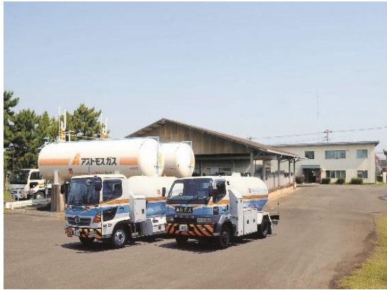
宮崎液化ガス(株) (LPガス事業)
