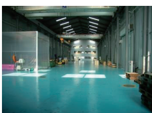
一般組立場 20t・5t親子クレーン2基 吊り治具で30tまで吊り上げ可能
