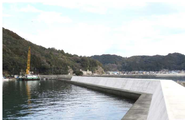
[防波堤の改良（高上げ）]
