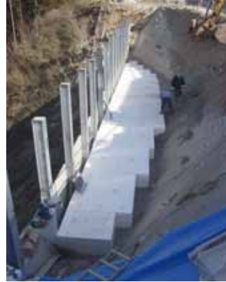
発砲スチロールを使ったE P S工法
