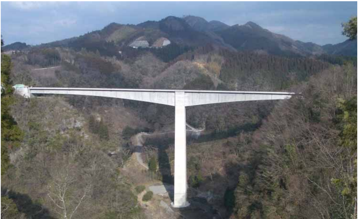
今年3月18日に開通したふるさと農道五ヶ瀬地区「夕日の里大橋」
