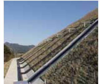
完成した排水溝。舗装や緑石等の工事が残されており、6月には完了の予定
