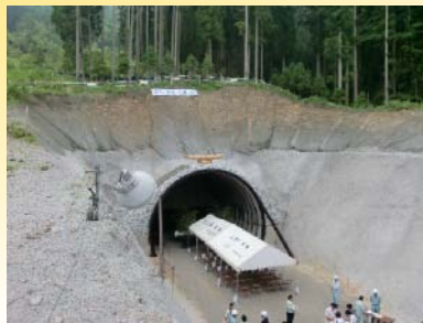
トンネル入口全景
