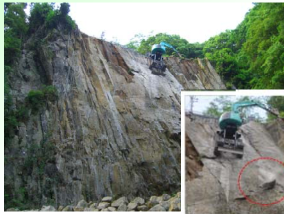
ロッククライミングマシーン作業状況
