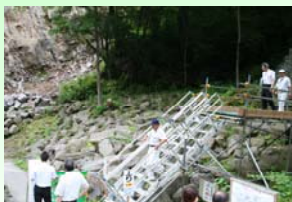
工事のため一部通行止め
