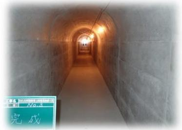
西臼杵地域には、先人達が山腹に築いた水路が形成されており、農業用水としての重要な役割を担っています。その一部は素掘りの隧道（水路トンネル）となっていて、老朽化に伴い天井や壁部からの落石が頻繁に発生し、維持管理に苦慮する箇所もあります。このため、県営ため池等整備事業等により水路トンネルの改修を行っています。既設断面は、人が立ったまま維持管理できる断面として設計しています。本地域にはまだまだ未改修の水路トンネルが多く存在しており、農業従事者の高齢化が進行する中で、維持管理がますます難しくなっています。
