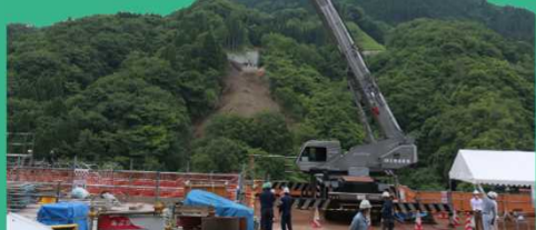
波帰之瀬橋（仮称）の工事現場の様子
