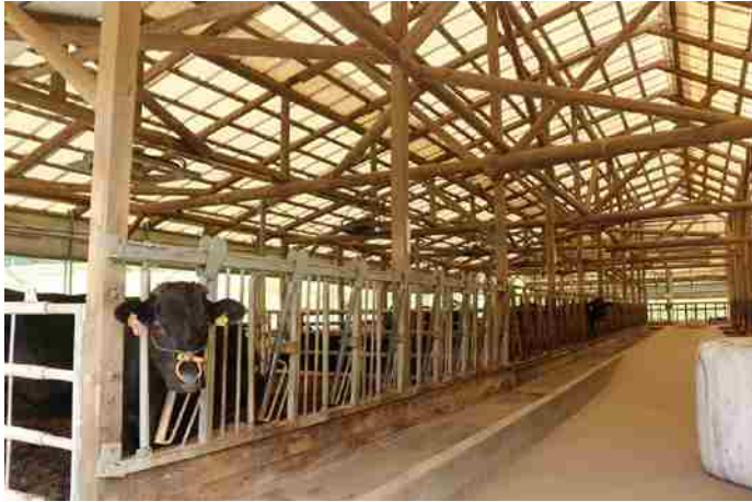
規模拡大のときに最初に建てた牛舎。田邊家の山から切り出した材木で作られている。
