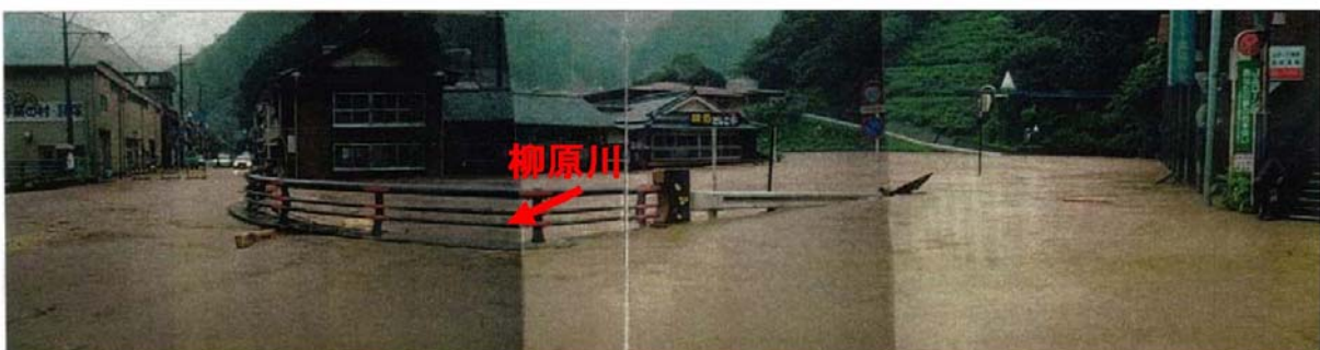
平成9年9月の被害状況(諸塚地区)
