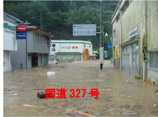
平成 16 年 8 月の被害状況(諸塚地区)
