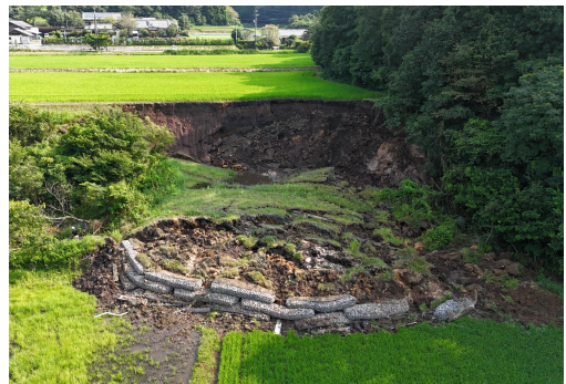
■農地（水田）の崩壊と 水路の埋没
