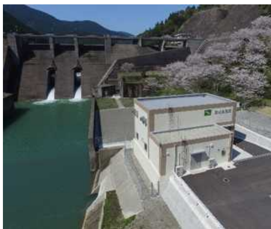
酒谷発電所と日南ダム
