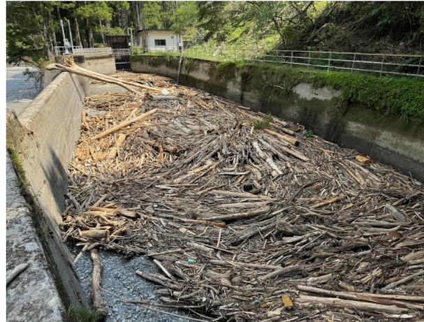
鬼神野取水堰 沈砂池流木堆積
