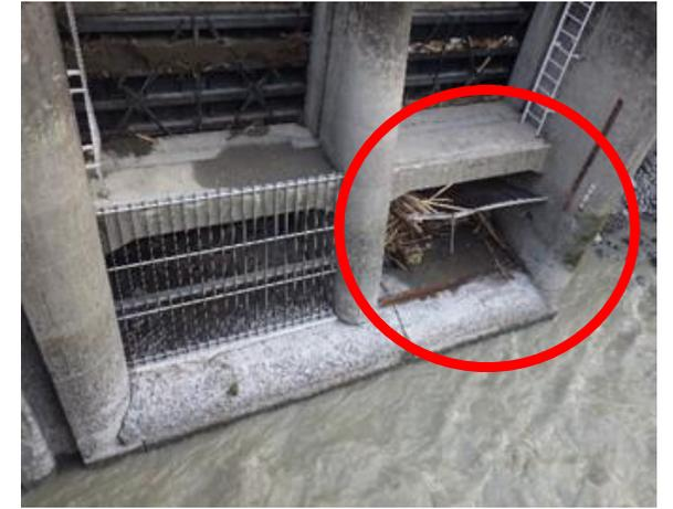
鬼神野取水堰 取水口スクリーン破損
