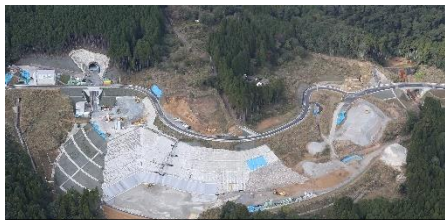
国道447号 真幸バイパス
