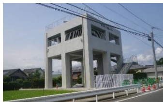
津波避難タワー（延岡市）
