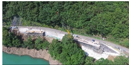
国道219号 越野尾二之渡工区
