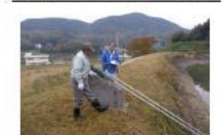
ため池の現地パトロール
