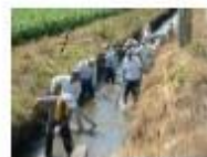
水路の泥上げ
