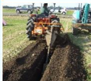
暗渠排水の整備
