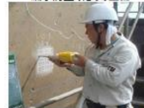
老朽化した施設の機能診断
