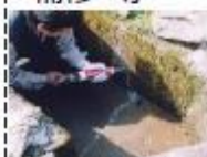
水路のひび割れ補修
