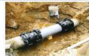
漏水防止のための整備
