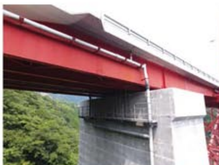
● 国道218号 千支大橋 (延岡市)
