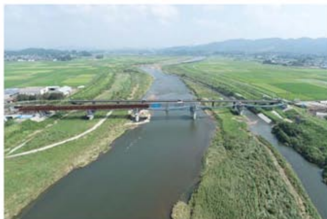
高城山田線 王子橋
