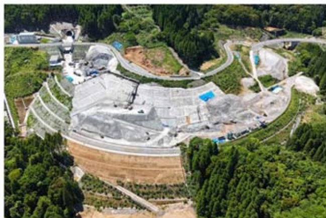
国道447号 真幸工区
