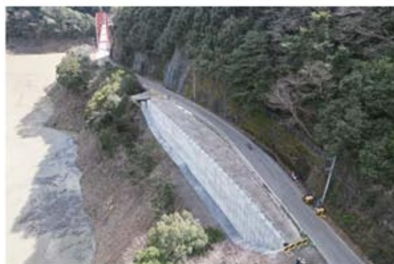
国道219号 越野尾二之渡工区
