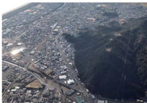
稲葉崎平原線(安賀多通線) 構口工区
