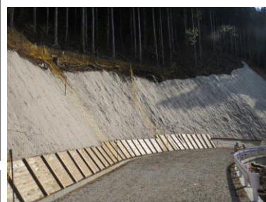
写真3 法面パネル等施工
