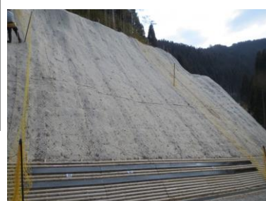
写真3 法面パネル等施工
