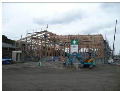
写真3 建て方の状況
