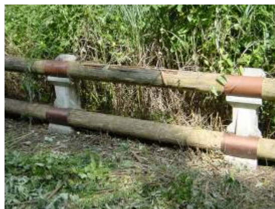
写真9 林道沿いの施工地
