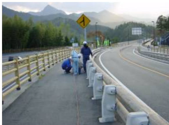
写真8 国道沿いの施工地
