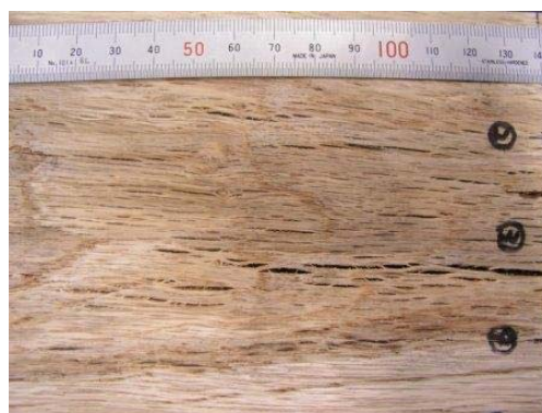
図3 心材部の大きな割れ
