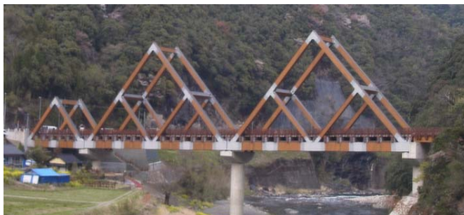
写真1 かりこぼうず大橋の外観
