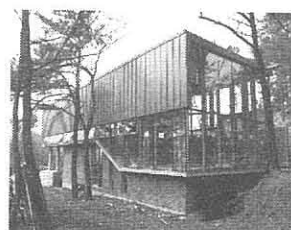
図-4 完成間近のテストハウス
