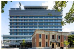
宮崎県防災庁舎 （宮崎県HPより）
