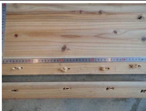
(v) ビス (MLT－受材接合) の損傷状況
