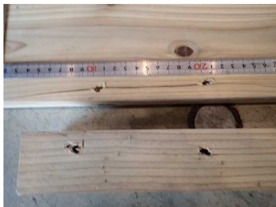
(v) MLT のひび割れ状況 (右端裏面上部)
