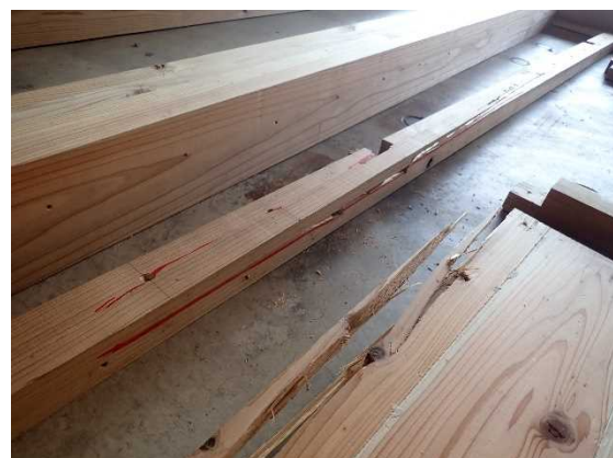
(vi) 受材の損傷状況（右端中央部）
