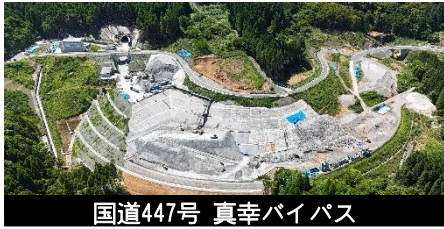
国道447号 真幸バイパス
