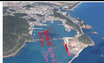
第10号岸壁（耐震改良） 重要港湾 油津港
