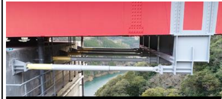
橋梁耐震補強(粘性ダンパー)
