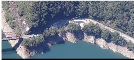
国道219号 越野尾二之渡工区
