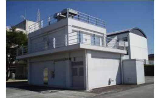
佐賀県消防学校 実火災訓練施設
