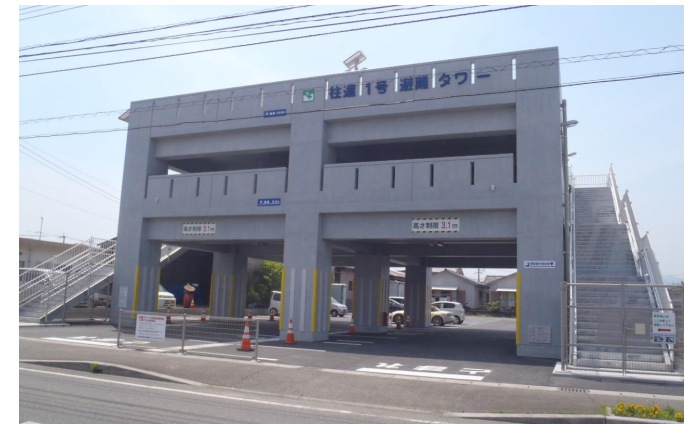
津波避難タワー（日向市財光寺地区）
