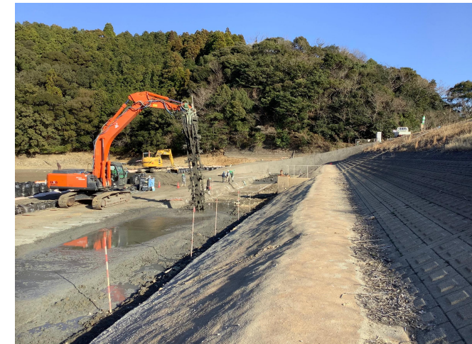
川島第一ため池の耐震化（延岡市）
