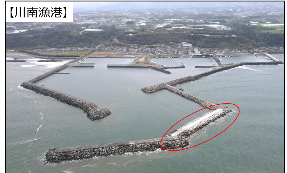
防波堤（新設、粘り強い構造化）
