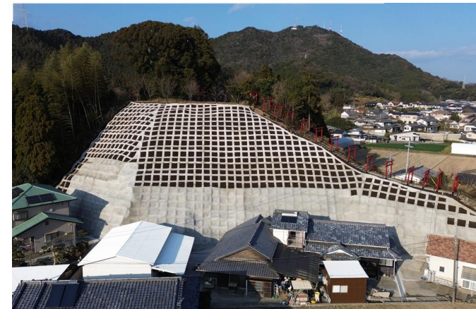
片田第7・8地区(急傾斜) 延岡市
