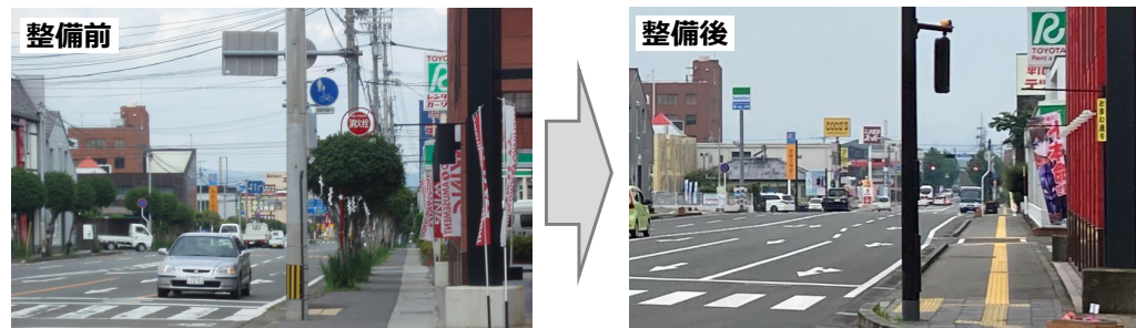
国道269号 栄町工区（都城市）
