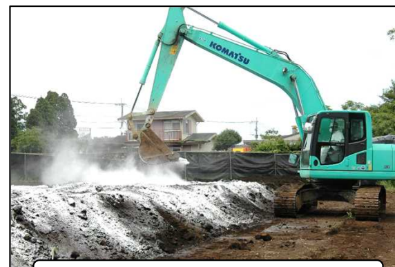
県建設業協会による埋却作業
