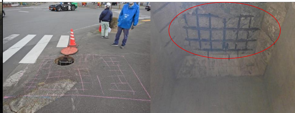
制水弁桝 頂版撤去新設工
