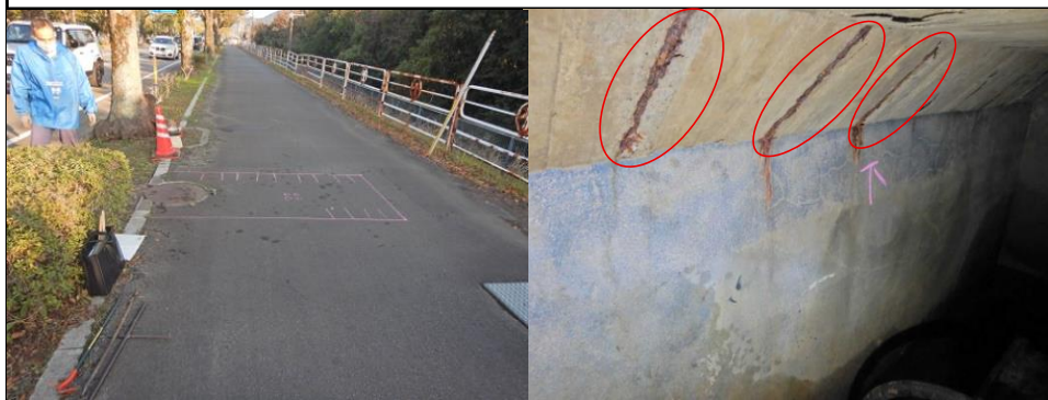
制水弁桝 断面修復工
