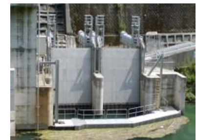
(参考) 猿瀬発電所除塵機
