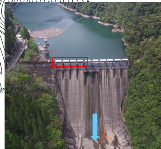
開閉装置 (下流側から望む)
