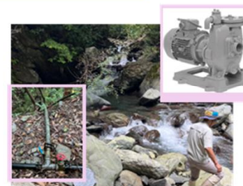
ポンプ整備、用水確保の施工
