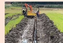
水田の暗渠排水整備
