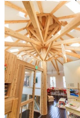
非住宅木造建築事例【あがた幼稚園(日南市)】
