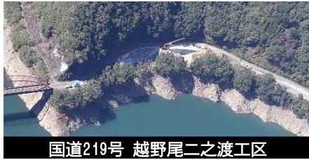
国道219号 越野尾二之渡工区
