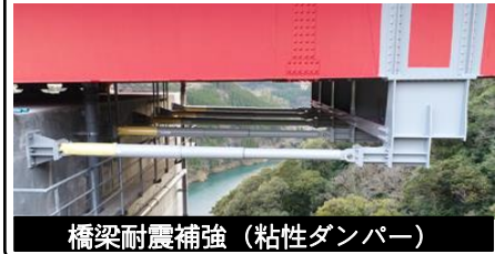
橋梁耐震補強(粘性ダンパー)
