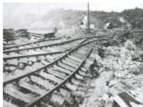
写真 4.2 流失破壊された日豊線 (清武町教育委員会所蔵)
