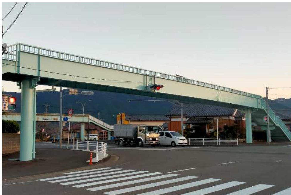
国道269号 寺町1号横断歩道橋
