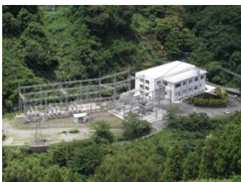
水力発電 規模: 最大28,000 kW
