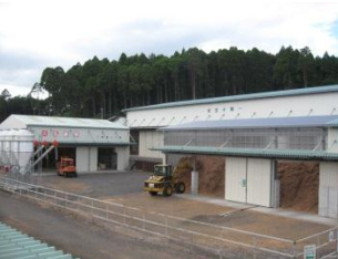
木質チップ・ペレット製造 規模: 10,000 t/年(チップ化) 1,200t(木質ペレット化)
