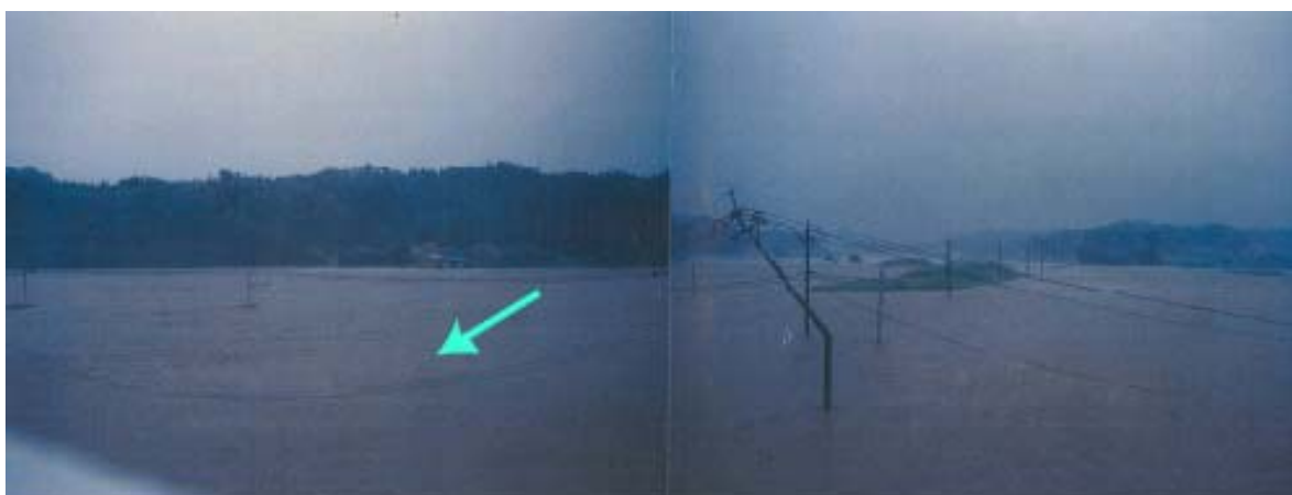
平成5年9月洪水（宮崎自動車道上流）
