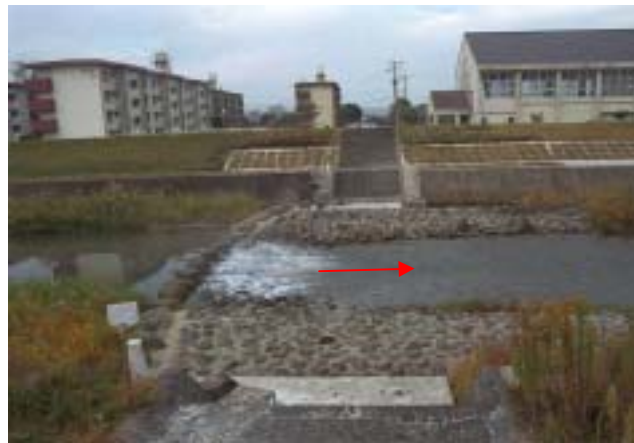
親水性に配慮した床止め (長江川：えびの市役所前)
