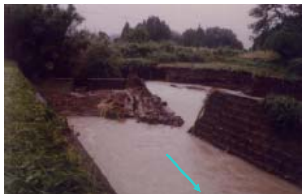
平成5年9月洪水（JR橋下流）
