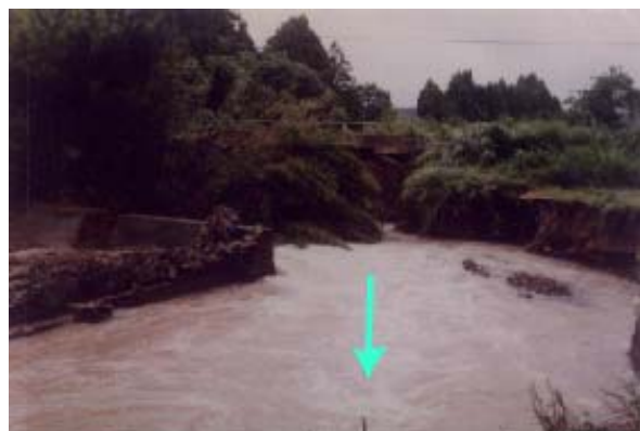
平成5年9月洪水（JR橋下流）
